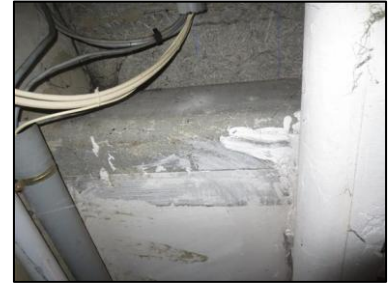
Photo N° 1284 AMIANTE CIMENT - -couloirs de caves Plafonds Ventilation haute (Fibres-ciment)
